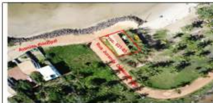
Figura 3: Vista aérea da destruição do imóvel a partir do aterroamento com drone. Data da Imagem: 02/06/2019.
