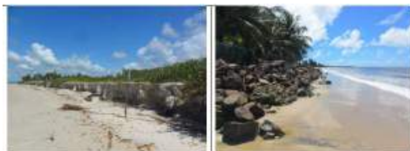
Figura 3. Segundo ponto a 300m (sul-norte) da ponta do saco ainda observa-se o processo erosivo e começam os barramentos com pedras. Coordenadas UTM (679511, 8735449).
