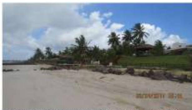
Foto 5G: proximidade particular construída com área pública sobre as dunas. Exatidão sobre o início da deposição de pedras de enrocamento.
