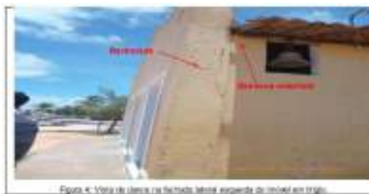
Foto 4: Vista da área da fachada lateral esquerda do imóvel em 11/11/15.
